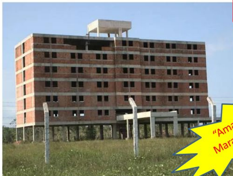
Construção de hotel foi abandonada após cancelamento do projeto (Foto: Miguel Nery/TV Mirante)
