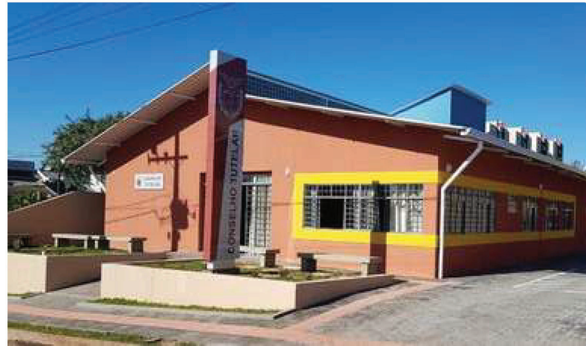
OBRA FINALIZADA – MARIALVA/PR
