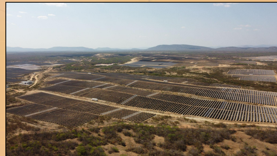
VISÃO PANORÂMICA DA USINA FOTOVOLTAICA EM PLENA ATIVIDADE Município de Coremas - OUT 2022
