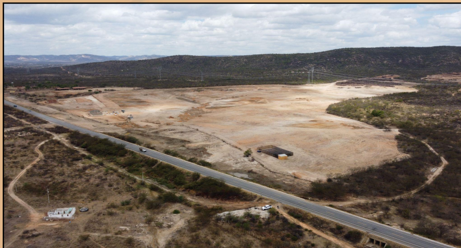
VISÃO PANORÂMICA DA USINA FOTOVOLTAICA EM CONSTRUÇÃO Município de São Mamede - OUT 2022
