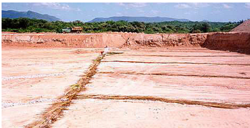
Figura 4 – Vista do sistema de drenagem de um aterrosanitário da região metropolitana de Fortaleza
