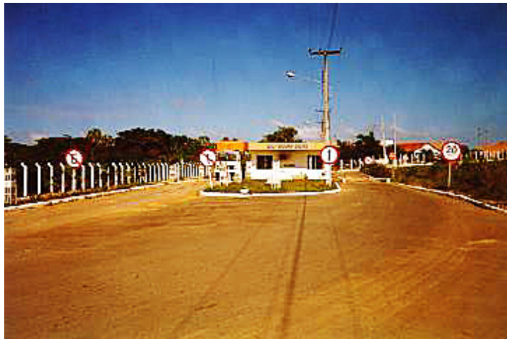
Figura 3 – Vista da entrada do aterro sanitário da região metropolitana de Fortaleza
