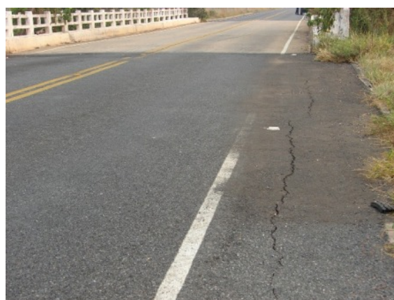
Foto 4 - Trincas longitudinais
